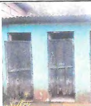
Foto 5: Puertas de los sanitarios dañadas, no cuentan con chapa para poder cerrarlas.
